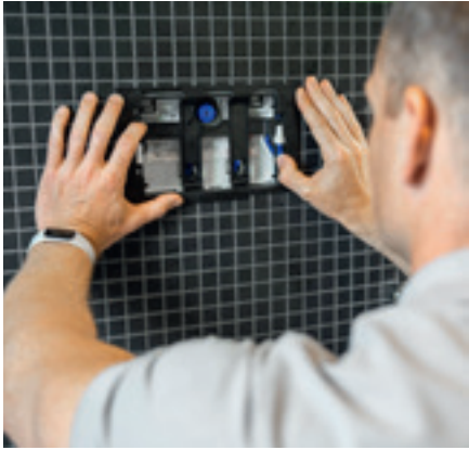
4 Den nye Sigma40 monteringsramme pla-ceres, fastgøres med afstandsboltene og spændes med låsekilerne.
