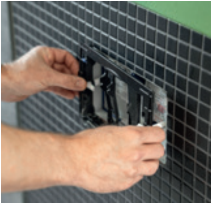
3 En drejning på 90° af afstands-boltene gør det nemt at fjerne den gamle monteringsramme.
