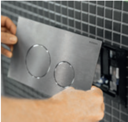
7 I det sidste trin klikkes Sigma40 betje-ningspladen på monteringsrammen. Et tydeligt klik bekræfter, at snap-in-meka-nismen er korrekt fastgjort.
