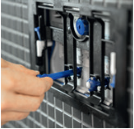
6 Han indsætter derefter stængerne i den korrekte længde, og fastgør dem med en drejning på 90°.
