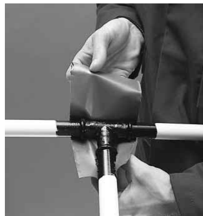
Billede 64: Påsætning af korrosionsbeskyttende tape
