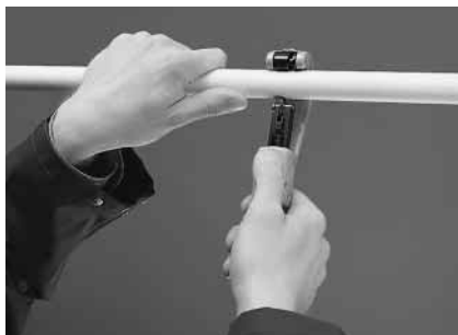
Billede 43: Afkortning af et kobberrør med en rørskærer
