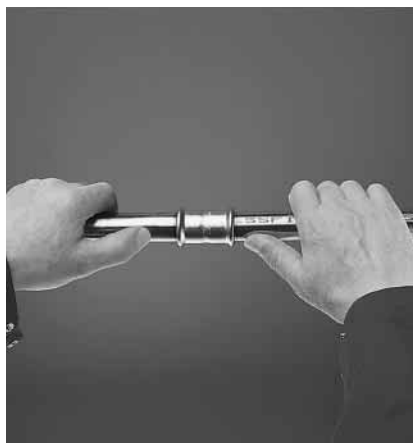
Billede 38: Indføring af et mapress rør RUSTFRIT eller FORZINKET eller et kobberør i en pressfitting.
