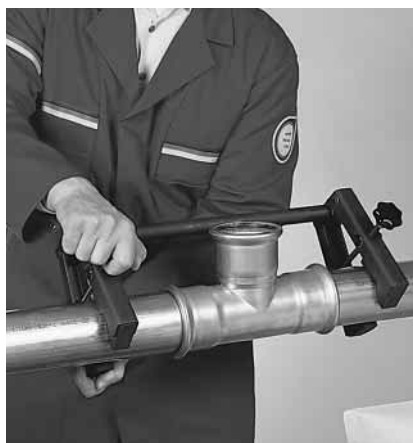
Billede 40: Påsætning af et montagefixtur
