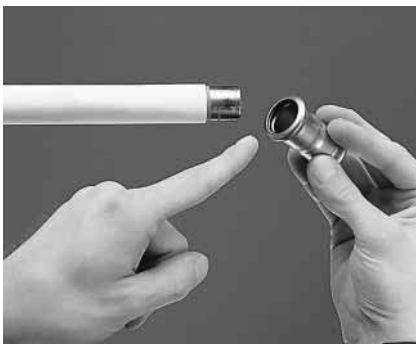
Billede 49: Kontrol af tætningsringen
