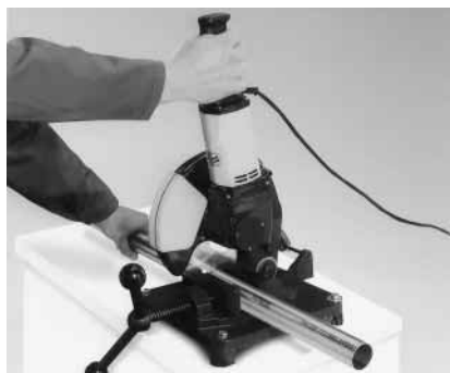
Billede 27: Afkortning af rør i rustfrit med en elektromekanisk kapsav.
