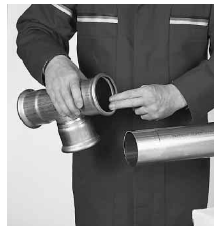
Billede 37: Kontrol af tætningsringen
