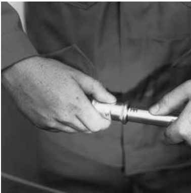
Figur 13: Indføring af rør i presfitting
