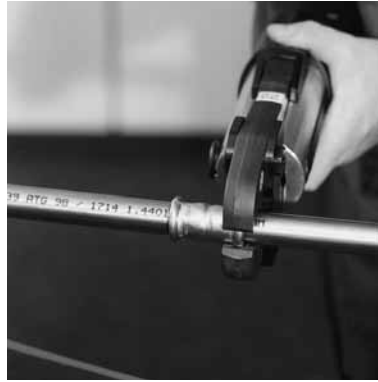
Figur 12: Presning med elektromekanisk presværktøj
