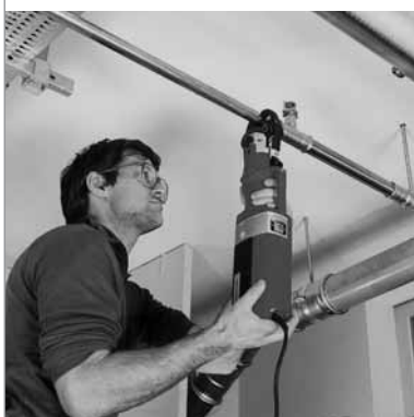
Figur 4: Presning med elektromekanisk presværktøj
